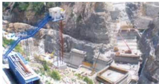
Ладење на бетон на голем опсег
