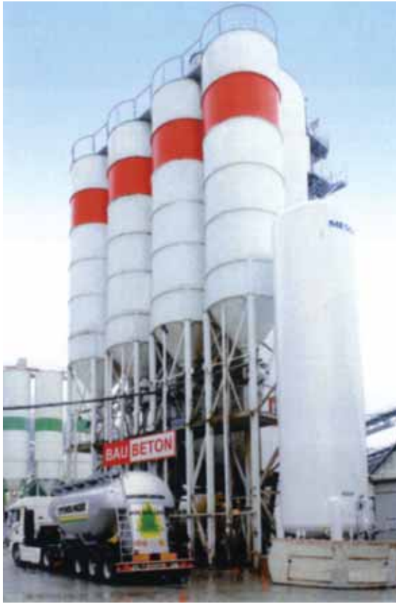
Ладење на цемент близу Innsbruck, Austria
